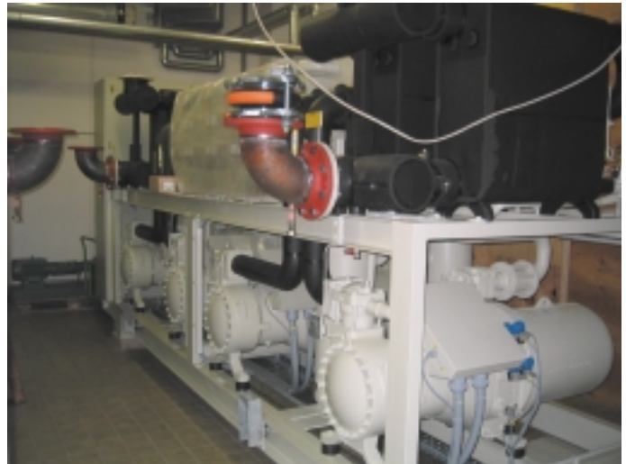
Einbau der Maschine
