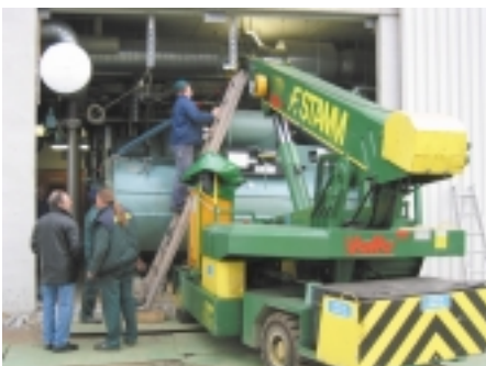
Die alte R11-Anlage wird demontiert
