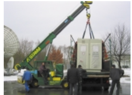
Anlieferung der neuen Kältemaschine
