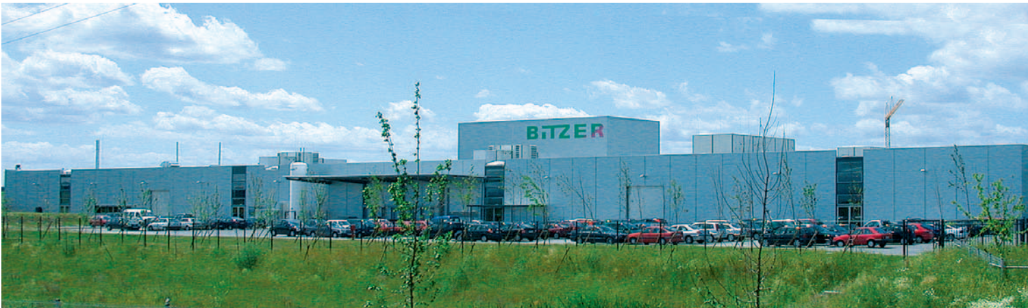
Im neuen Bitzer-Werk in Rottenburg-Ergenzingen wird die neue Generation von Schraubenverdichtern der CSH-Serie hergestellt.
